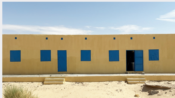
Ecole en matériaux définitifs construite par la SONIDEP-SA pour la population de HADARA (Commune rurale de N'gourti)
